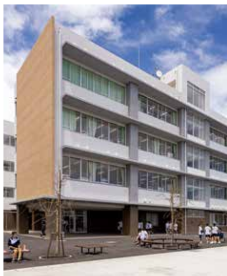
グラウンドに面したピロティ
