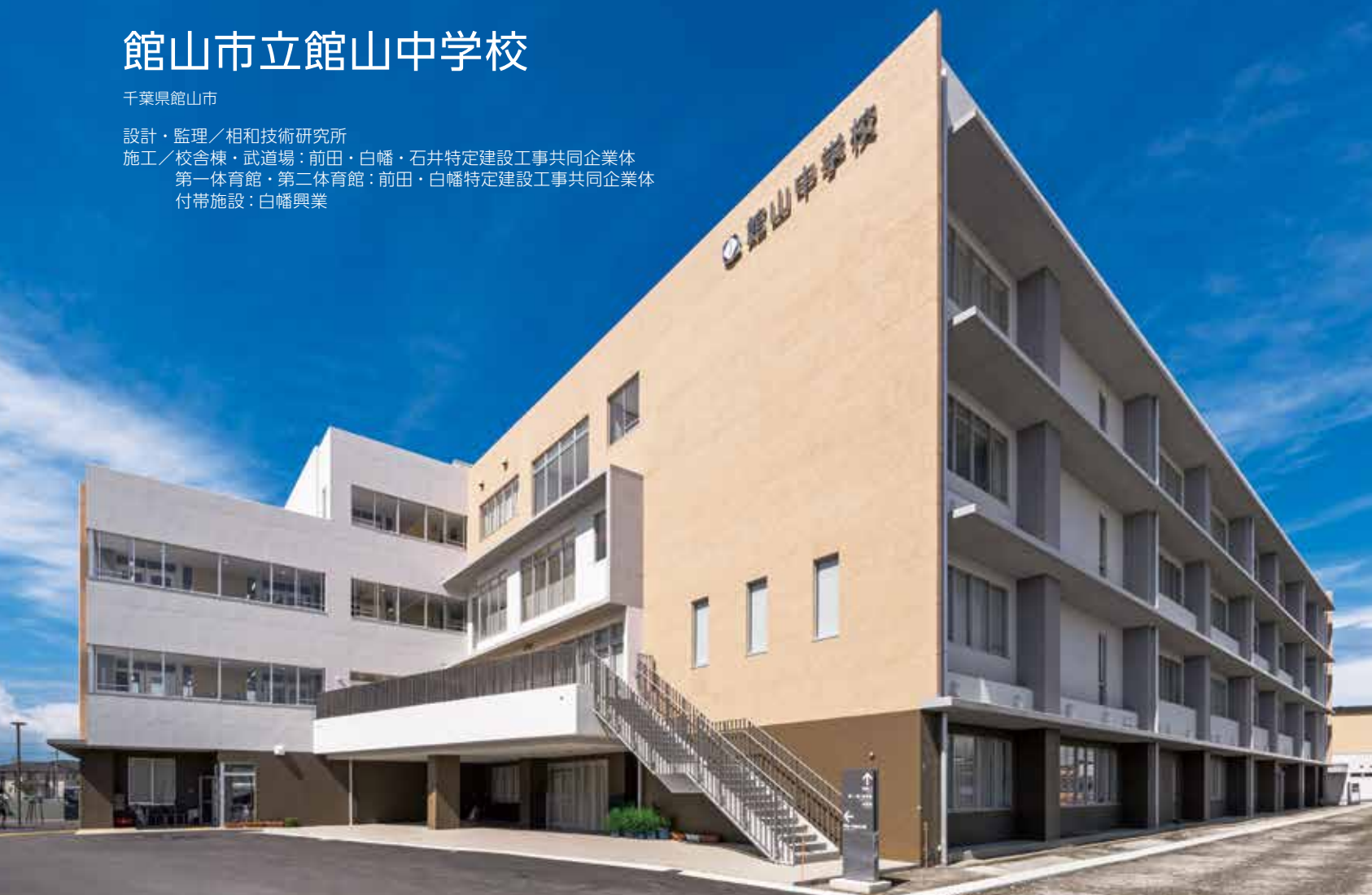
敷地東側からの外観
